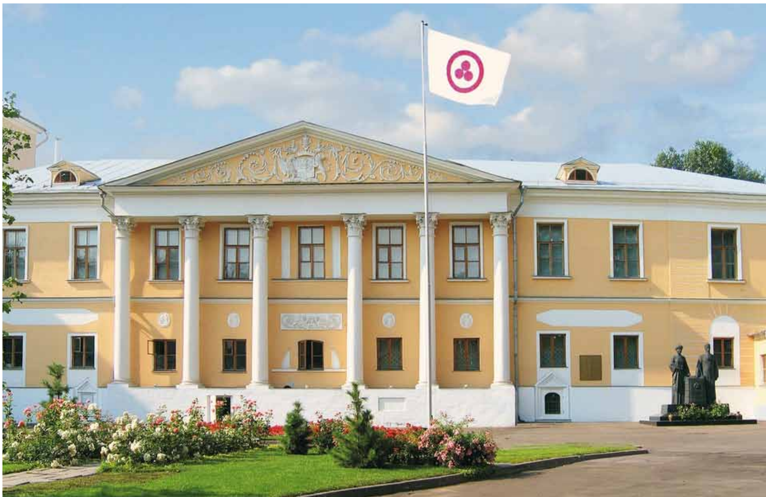
Усадьба Лопухиных, где уже 26 лет располагается Общественный музей им. Н. К. Рериха. Теперь над ним нависла угроза
